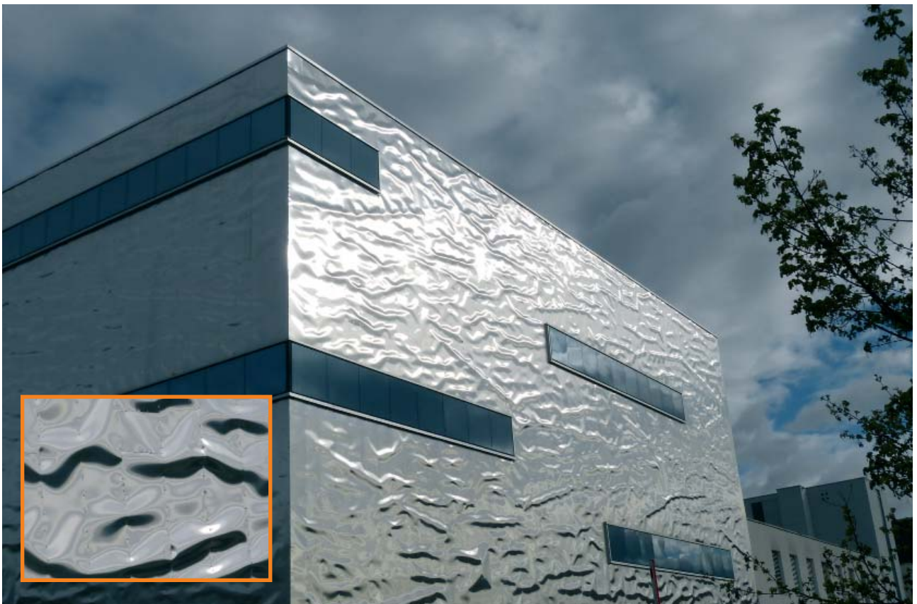
Cet entrepôt est certes recouvert de métal fortement réfléchissant. Mais en raison des plissements du métal, la façade ne devrait pas être un danger pour les oiseaux.
