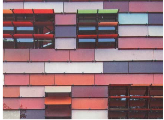
Les verres utilisés dans ce cas sont translucides, de petites dimensions et peu réfléchissants. Les oiseaux peuvent bien les reconnaître.
