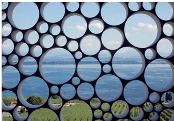
Mise en scène ludique de la vue – et en même temps protection efficace contre les collisions (placé devant la façade).
