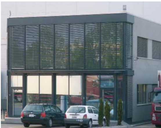
Verre de protection solaire à l'entrée d'un bâtiment commercial. Les pare-soleil de l'étage supérieur réduisent fortement les réflexions.
