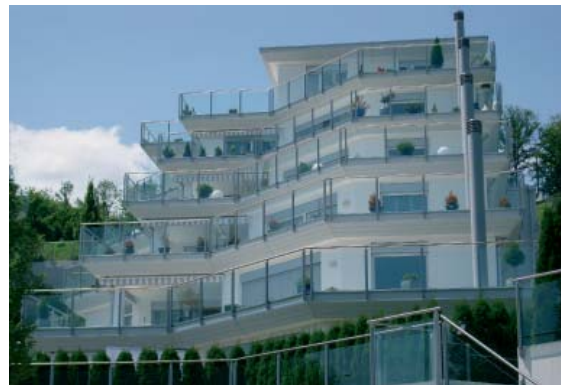
Dans ce lotissement, l'intégralité des balustrades de balcon et autres barrières a été réalisée en verre transparent.
