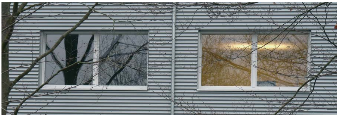
La réflexion dépend de nombreux facteurs dont l'éclairage intérieur. Le même type de verre réfléchit plus fortement, si l'arrière-fond est sombre.
