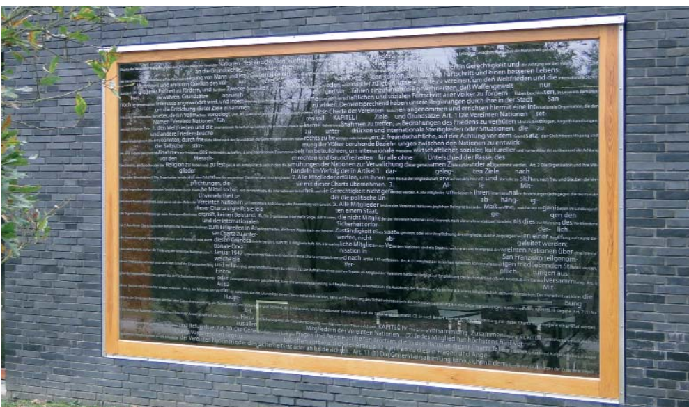
Marquage innovateur d'une vitre réfléchissante sur l'office des affaires étrangères à Berlin-Tegel.
