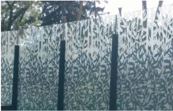
Paroi antibruit: efficace malgré le motif végétal.
