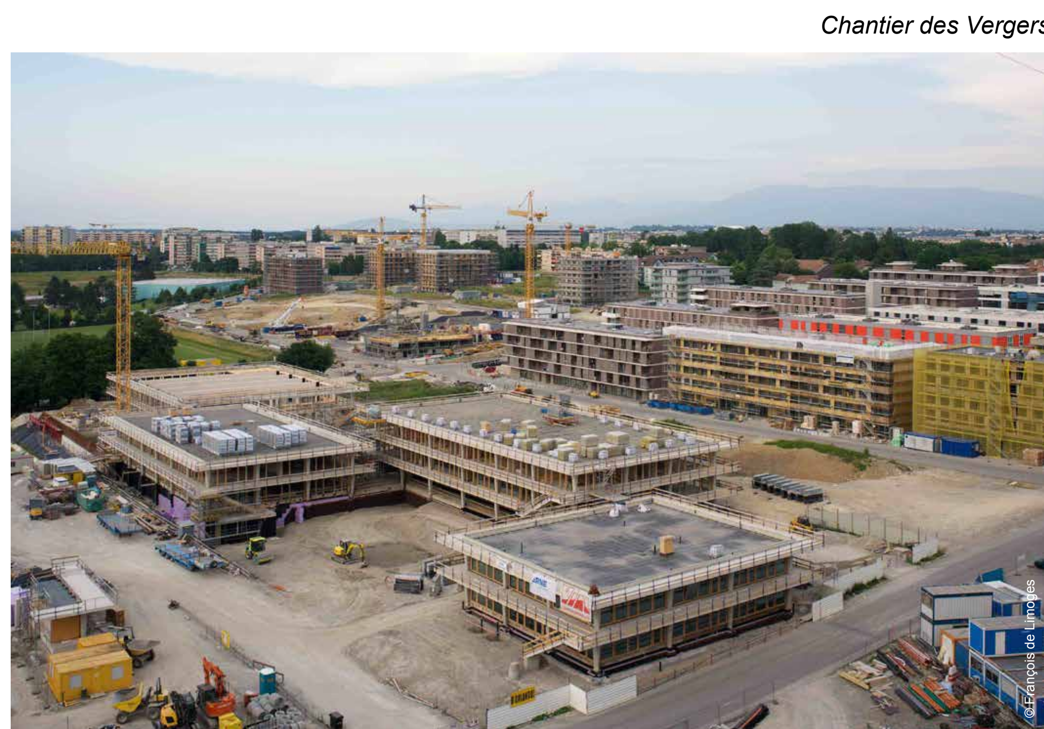
Chantier des Vergers
