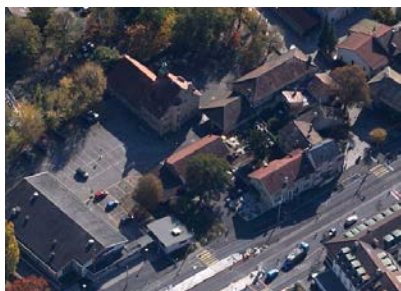
Les bâtiments communaux, avec le café de la Poste (Source : Bing, Microsoft)
