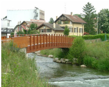
Passerelle piétons-vélos sur la Versoix. (Urbaplan, Cera, Gren)
