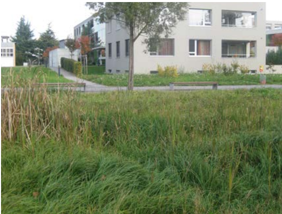
Bassin de rétention (ex. Pralée, Nant de Cuard)
